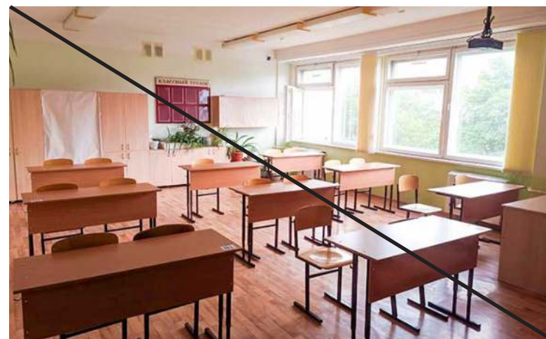
Плохо Линолеум под дерево
